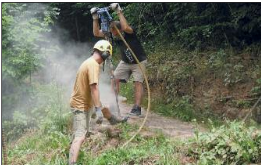
Vrtání děr do skály pro nové zábradlí podél pěšiny ke zvoničce
