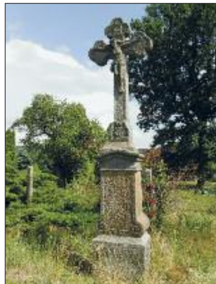
Křížek U Mandle před opravou
