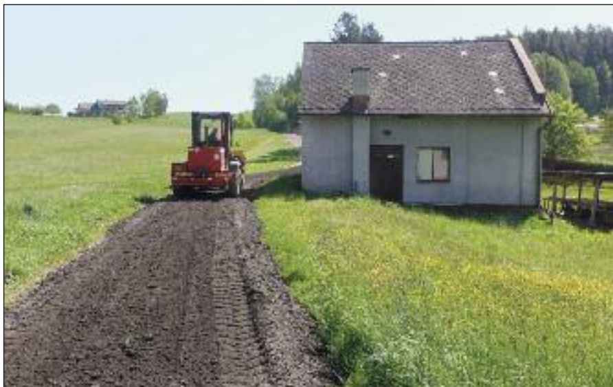
Úprava šterkové komunikace Na Výsluní
