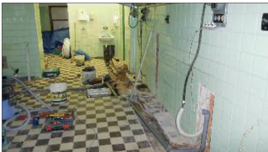
O letních prázdninách došlo ve školní kuchyni k výměně rozvodů vody a odpadů
