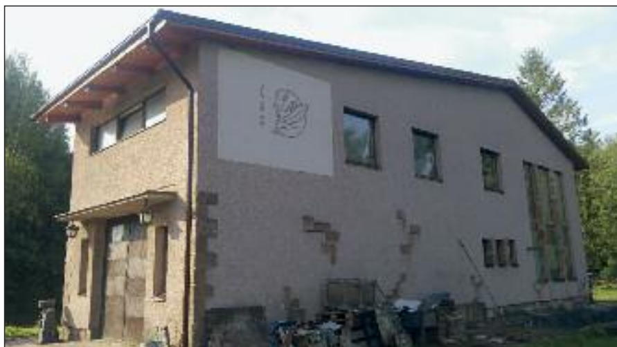
Kompletní výměna střešní krytiny na hospodářské budově
