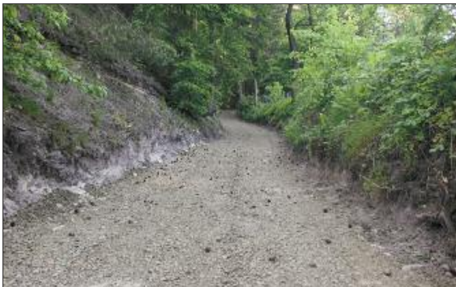
Opravená obecní komunikace k hradu Vízmburku
