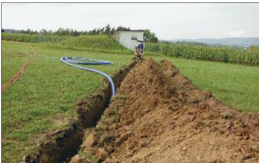
Bagrování výkopu pro vodovodní potrubí do vodojemu
