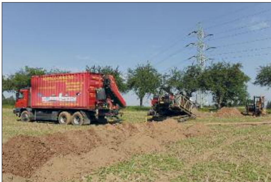
Podvrtávání asphaltové komunikace na Králově kopci pro nové vodovodní potrubí
