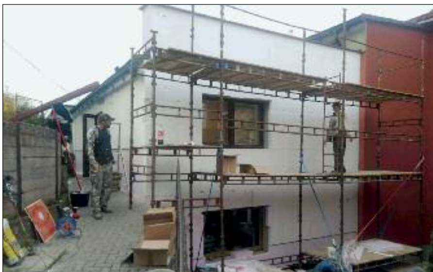
Zateplování ubytovny s tělocvičnou TJ Sokol Havlovice
