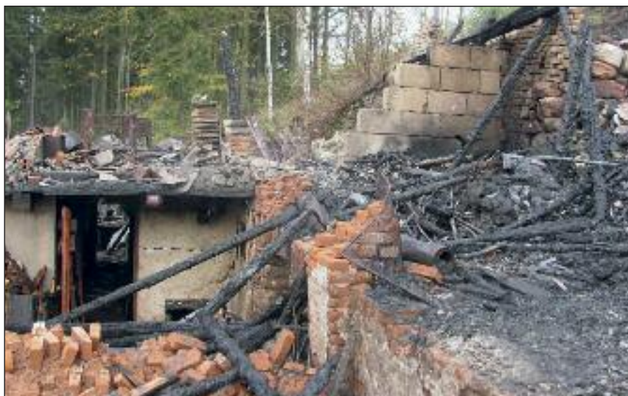
V říjnu požár zcela zničil rekreační chalupu v Muchově
