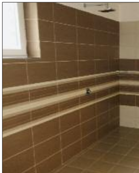
Sprchy v sauně po opravě
