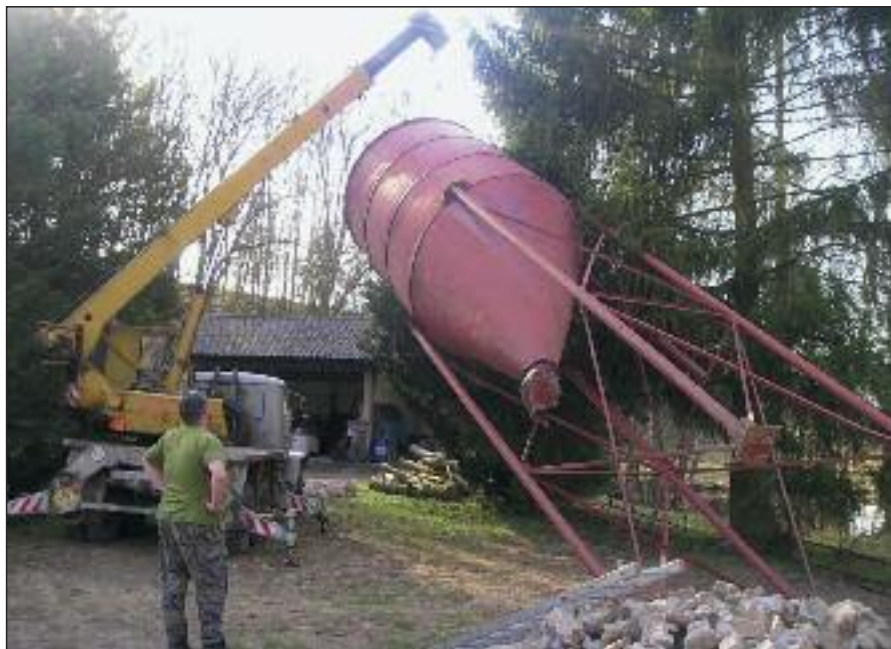
Usazení zásobníku na zrní u výtažníku Jindra v Havlovicích
