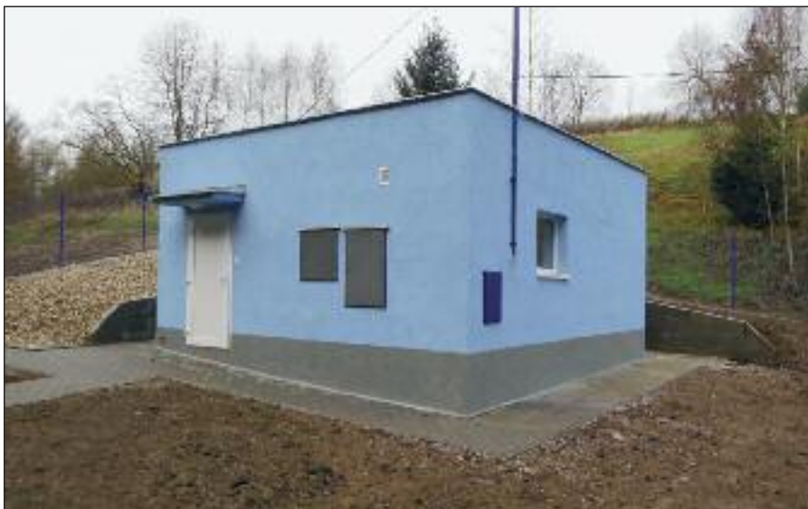
Čerpací stanice v Muchově po rekonstrukci
