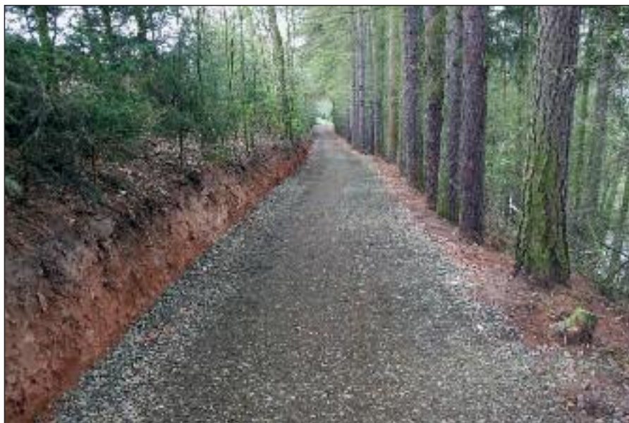
Opravená šterková cesta Nad Jutou k Úpici
