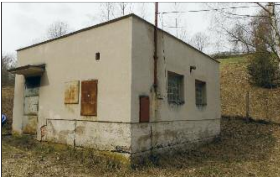
Čerpací stanice před rekonstrukcí
