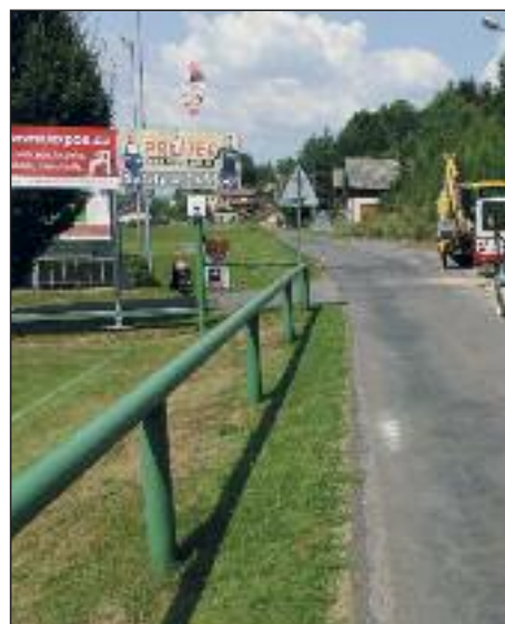
Rozšiřování komunikace podél hřiště
