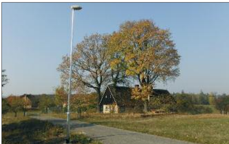
Nové veřejné osvětlení na Podhradí
