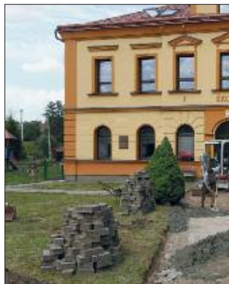
Zpevňování podloží a rozšiřování zámkové
