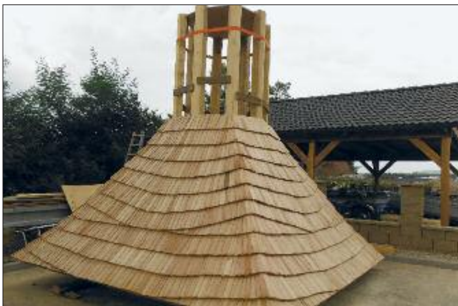
Dvojitý dřevěný štípaný šindel nahradil původní eternitové šablony
