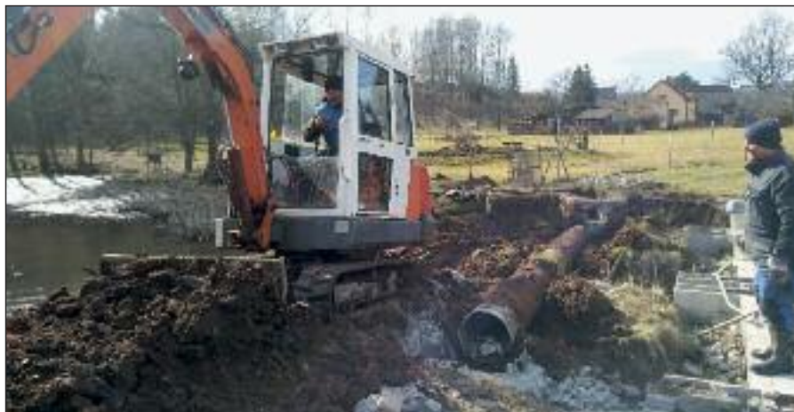
Rekonstrukce části přivaděče vody
