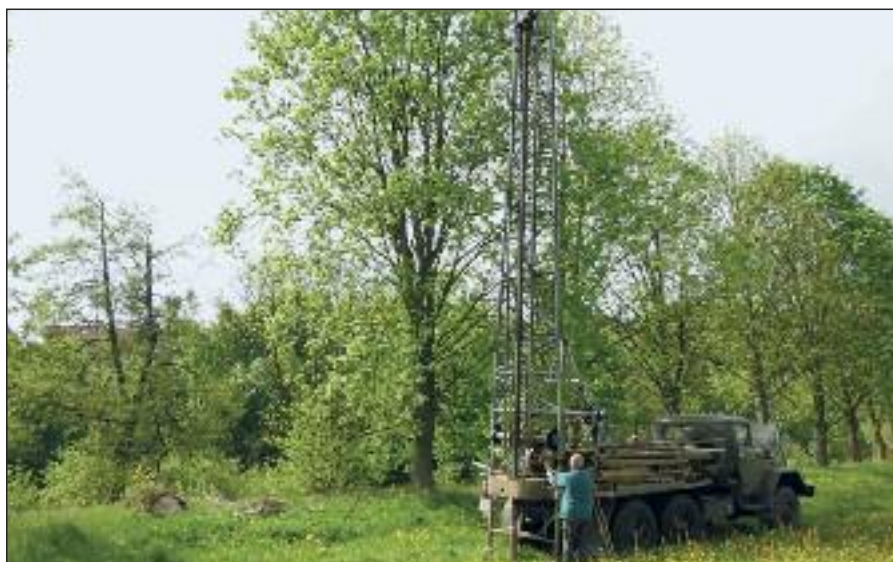
Geologický průzkum podloží v místě budoucí cyklostezky
