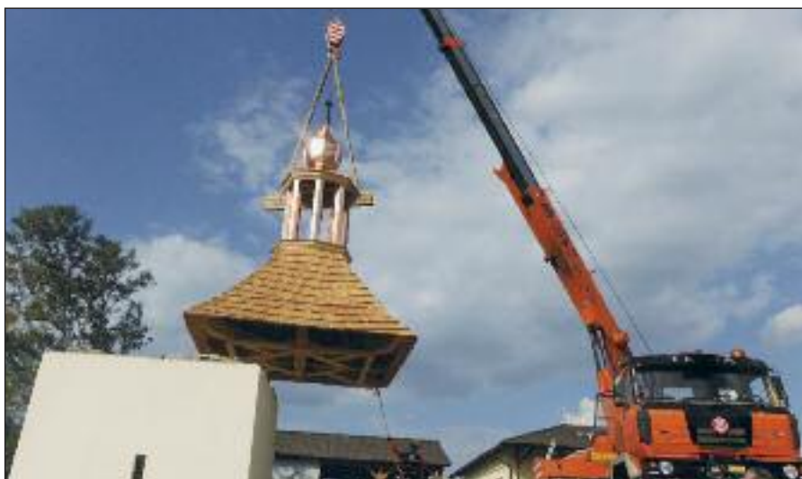
Nová střešní konstrukce se vrací na původní místo
