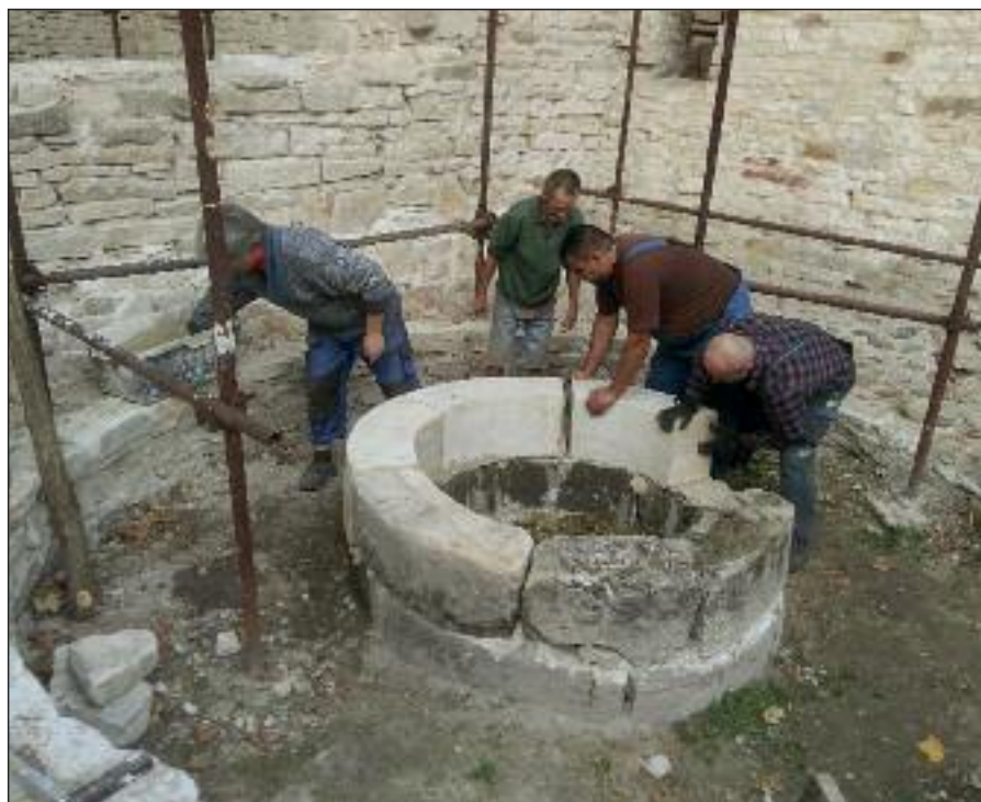
Oprava studny na nádvoří
