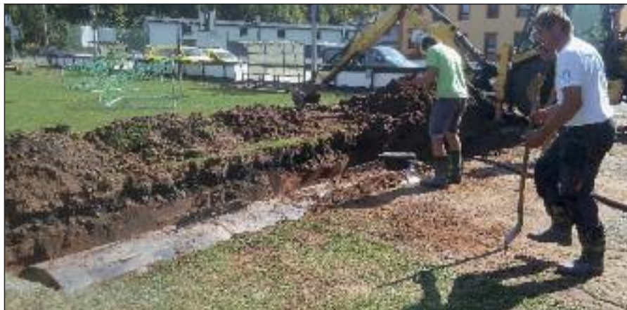
Usazování nádoby o objemu 18 m 3 na zavlažování trávníku
