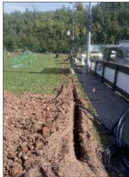
Pokládka PE trubek na umělé zavlažování
