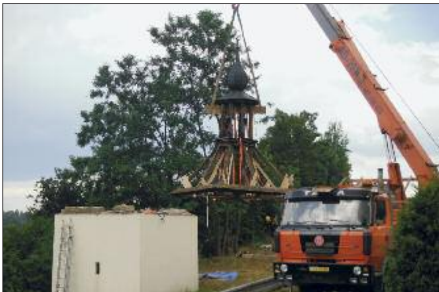
Autojeřáb přemísťuje původní střešní konstrukci
