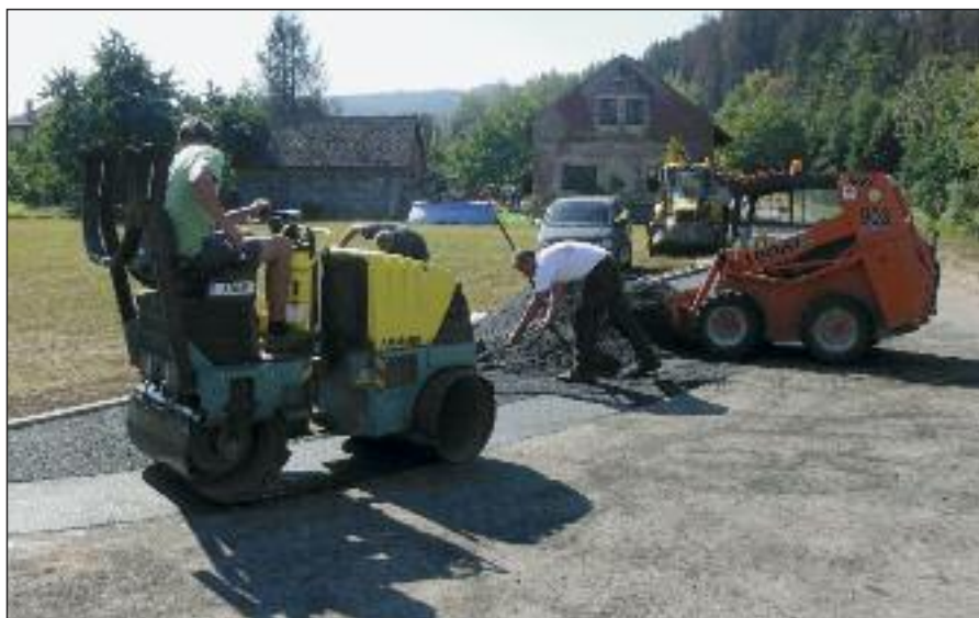
Rozšíření nájezdu na dřevěnou lávku
