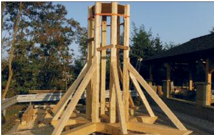
Ručně tesaná replika původní střešní konstrukce
