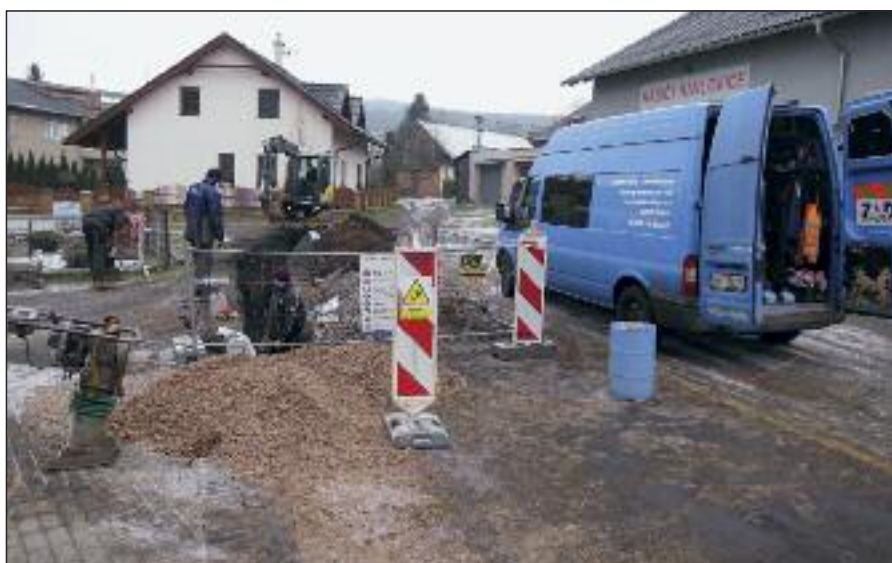
Výměna hlavního řádu obecního vodovodu za kulturním domem
