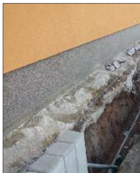
Oprava zídky podél školy na straně ke kluzišti
