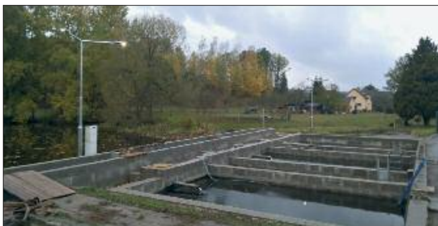
Nový přivaděč vody včetně osvětlení
