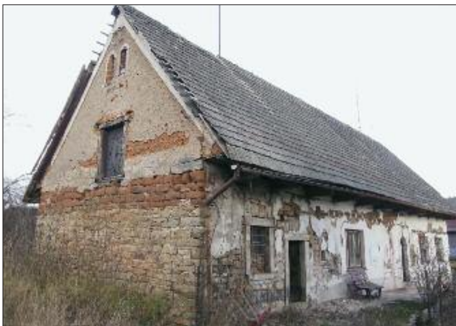
Hospodářské stavení č.p. 59
