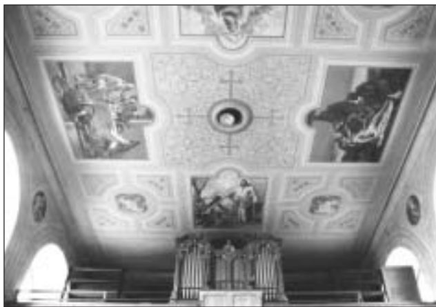
□ Výmalba stropu a varhany z r. 1907.
