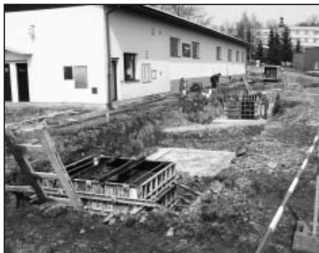
□ Betonáž základových patek pro stavbu zastřešeného nástupiště.
