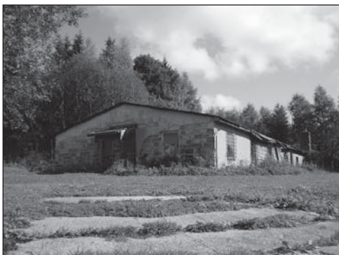
☐ Budova, ve které vznikne provozovna rychlého občerstvení. Foto: Jan Morávek
