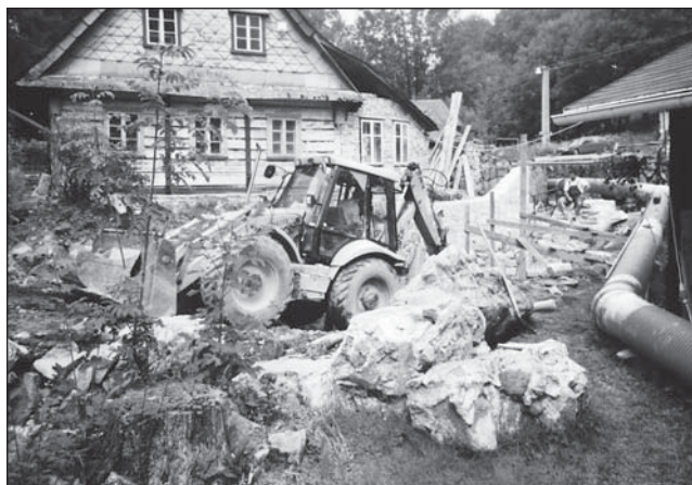
□ Bartošovice čp. 51. Vodou podemílaný dům je teď poddolovaný. Foto: Petr Zámečník.
