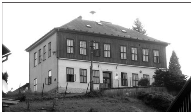
Škola před rekonstrukcí.
