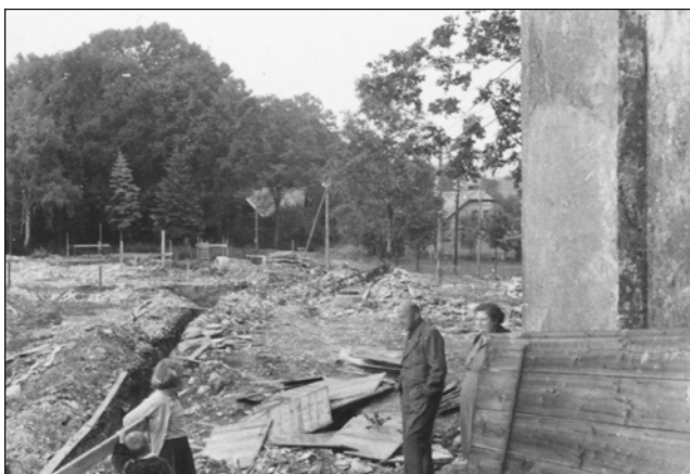
❑ Unikátní snímek ze stavby současné budovy školy v r. 1960. Na staveništi jsou prozatím vyhloubeny první základové rýhy. Na snímku vpravo je zachycen ředitel školy Josef Kubíček. Archiv ZŠ
