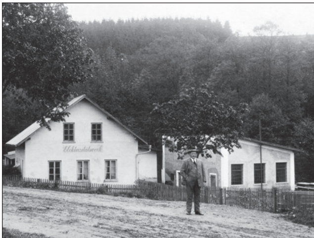
☐ Snímek domu čp. 136 s elektrárnou z doby okolo r. 1936. V popředí tehdejší majitel p. Holenda.
