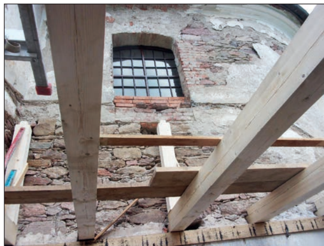
□ Stavba střechy na sakristii
