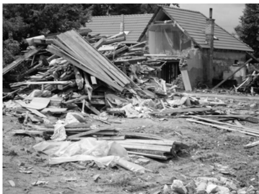
Jeden z domů, který byl zdemolovaný v důsledku letošních letních povodní na Jesenícku.
