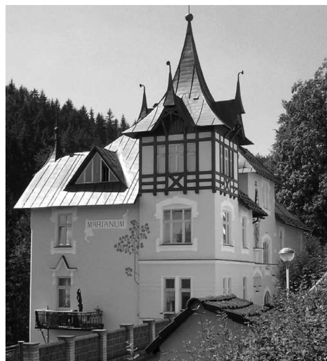
Opravená budova Mariana, autor: Dominik Melichar
