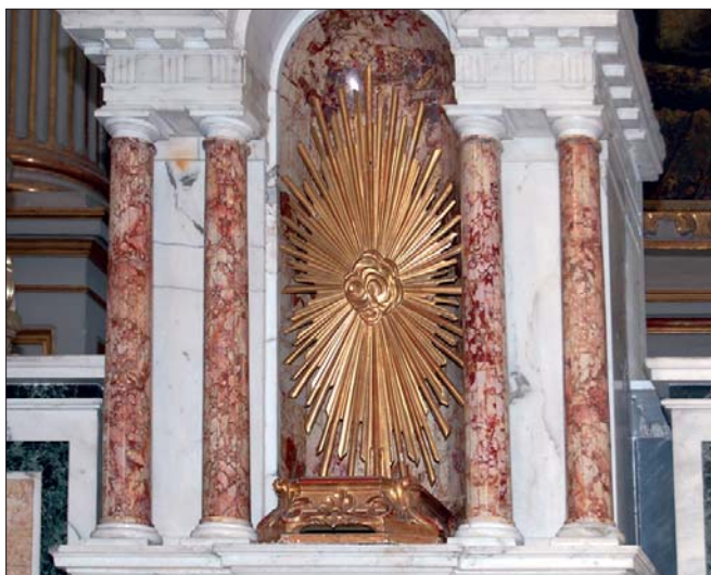
● Sloupky u barokního svatostánku, detail hlavního oltáře, Torre del Greco, Basilica Pontificia Santa Croce
