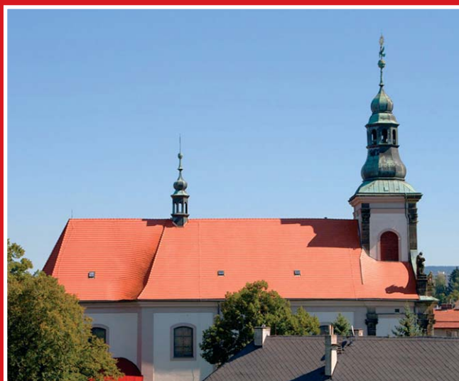
● Nová střecha v plném lesku
