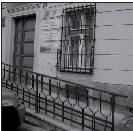
Bezbariérový vstup do objektu č. p. 3
