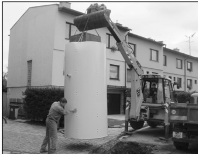
Osazování čerpací stanice v ulici Na Úpě
