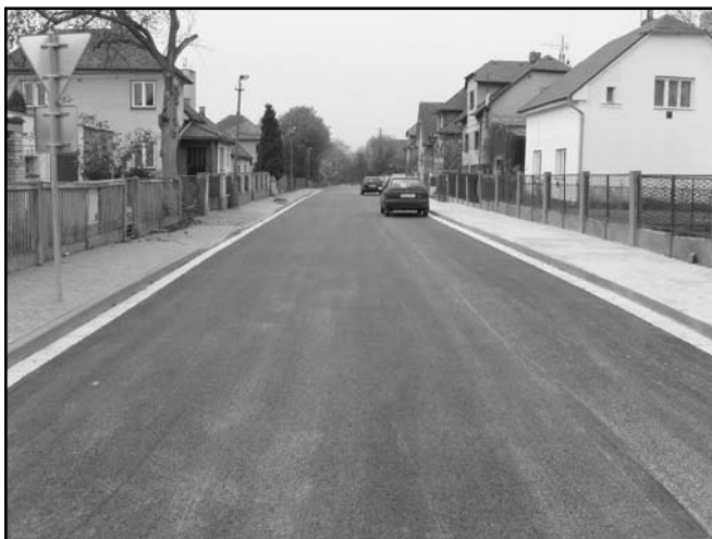
Komunikace Obránců míru v Jaroměři po opravě.
