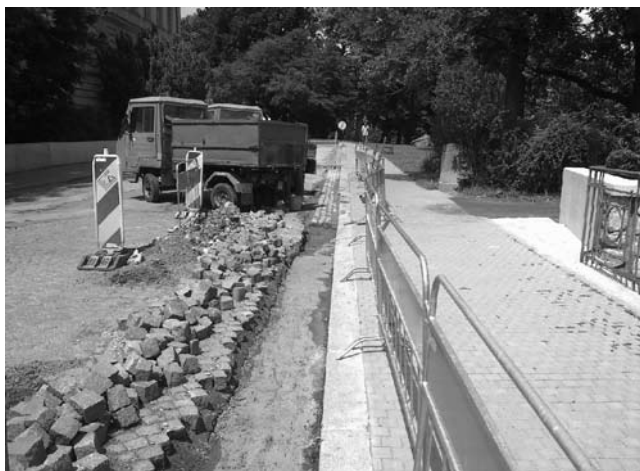
oprava komunikace ul. Na Ostrově
