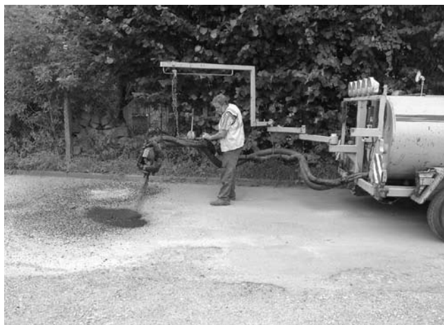
vysprávka komunikací kationaktivní asfaltovou emulzí
