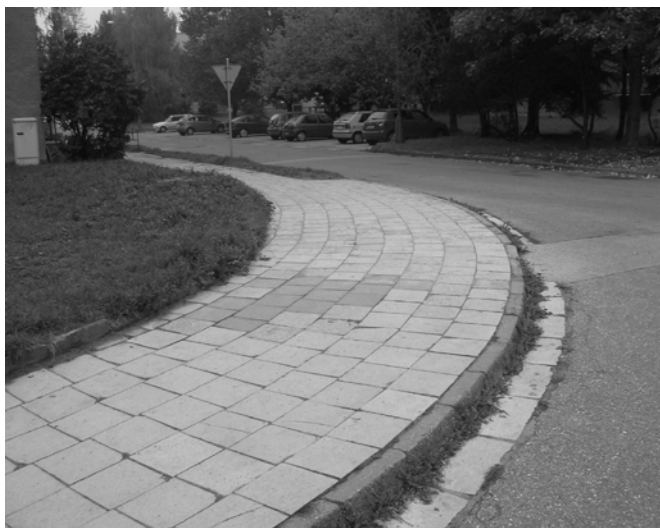
Předláždění části chodníku na sídlišti Na Ptákách
