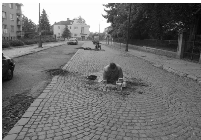
Oprava komunikace před gymnáziem (foto TSM)
