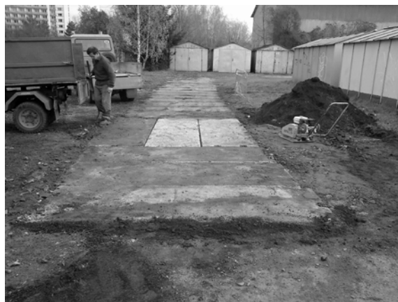
ul. Nádražní - výměna panelů
