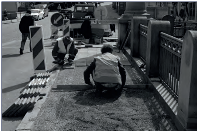
Oprava chodníku na Tyršově mostu
