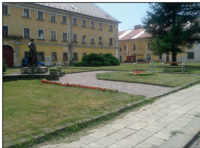
Úprava Riegrova náměstí v Josefově. Vyštěrkování chodníčku u sochy Josefa a instalace nových laviček.
