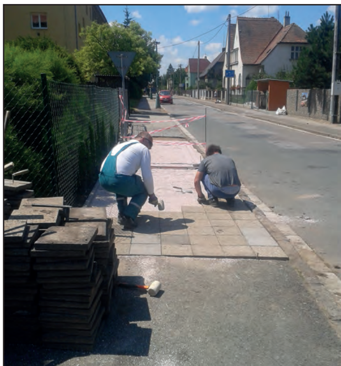
Oprava chodníku v ul. Na Zavadičce naproti Telecomu.
