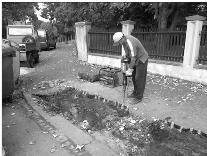
Úprava chodníku pro kontejnery na tříděný odpad v Lužické ulici
