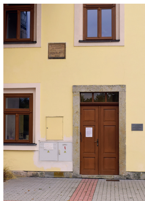
Vstup do budovy v přízemí ze strany parkoviště Na Valech.
