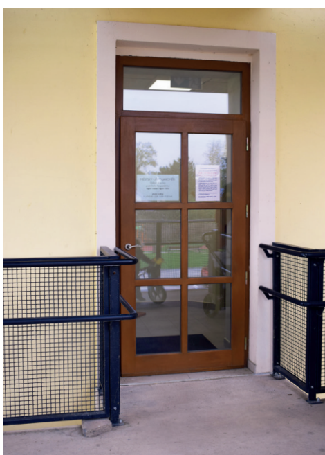
Vstup do budovy na registr vozidel a registr řidičů v prvním patře ze strany parkoviště Na Valech.
