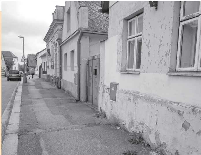
Současný stav chodníku v ulici Jaromírova.
