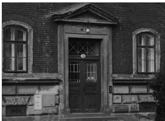
U vchodu do Správní a obytné budovy, tzv. červeného domu, jsou stále patrné bílé šipky označující protiletectký kryt.
