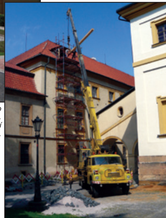
Právě probíhá první etapa prací v krovu jičínského zámku - lokální výměna nejpoškozenějších prvků. Z boční strany naproti kostelu sv. Jakuba Většího nyní stojí lešení a na fotografii z 18. 8. 2009 můžete vidět, jak se nahoru dostávají dlouhé, ručně tesané trámy.
