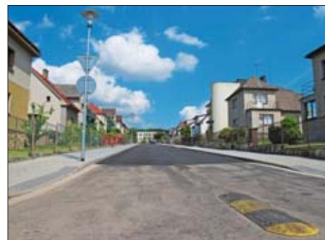
Obyvatelé Čerňovské se dočkali další zrekonstruované ulice. Během května a června byla kompletně obnovena ulice Fibichova, a to za cca 1 milion korun.
