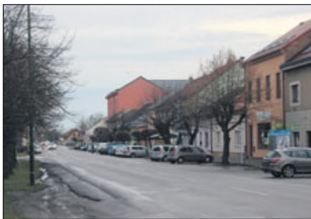
Ulice Ruská, Poděbradova a Lidické náměstí představují dopravní tepnu. Rekonstrukce bude náročná
