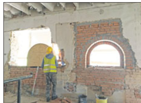
Budova bude osazena původními, repasovanými dřevěnými okny z roku 1923
