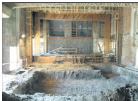
Pohled do kinosálu, foto z počátku rekonstrukce
