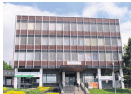
Současná podoba budovy na autobusovém nádraží
