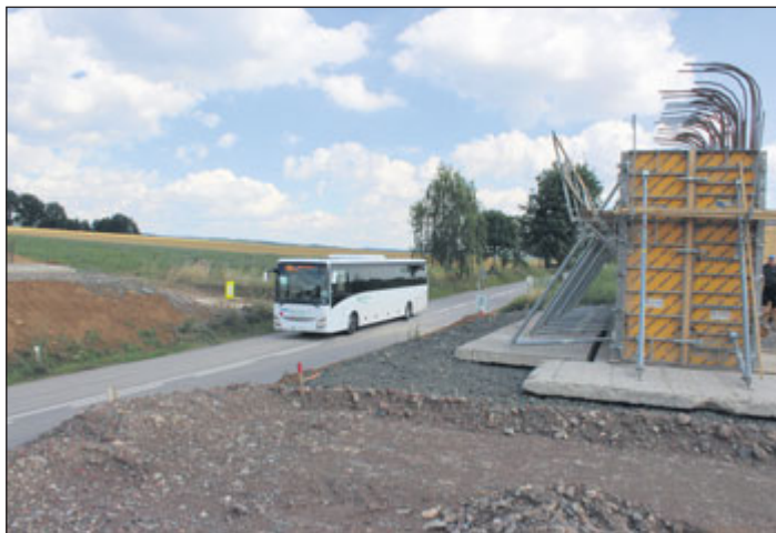
V současnosti probíhá výstavba mostu mezi Valdicemi a Studeňany
