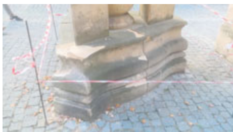
Poškození po nárazu těžkého vozidla bylo patrné a vážně narušilo statiku sochy
