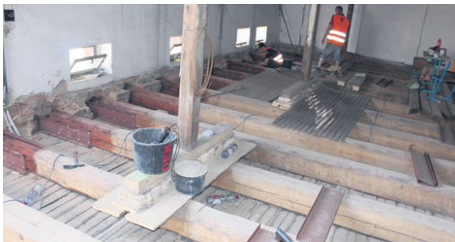
V podkroví nad jídelnou ZŠ Husova probíhá výstavba učeben
