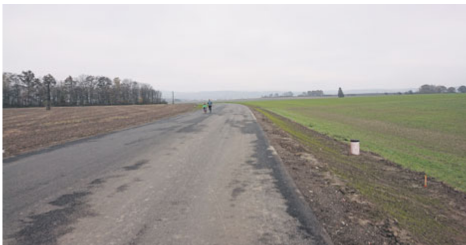
Prozatím je položena základní vrstva asfaltu, stavební práce se mají dokončit do května 2021. Což ale nebrání tomu vyrazit si zaběhat nebo se projet na kole. Přeložka nabízí netradiční pohledy na Zebín, Valdice a na kartouzu
