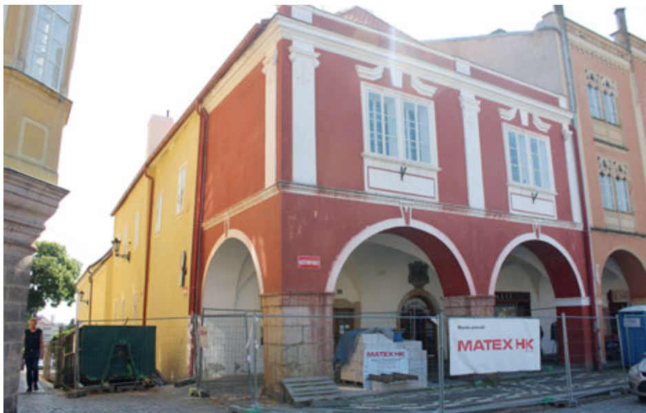
Regentský dům, Valdštejnovo náměstí čp. 2, prodělává celkovou rekonstrukci střechy, která byla již v havarijním stavu. Objekt využívá například K-klub pro kroužky, které organizuje
