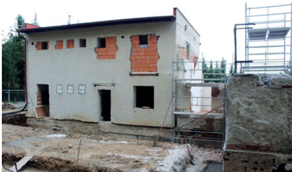
Právě probíhá rekonstrukce stacionáře Domovinka, který se nachází v Hofmanově ulici. Změní se kompletně vnitřní dispozice, bude přestavěn vnější plášť a zrevitalizovány plochy v okolí budovy. Stacionář poskytuje denní služby seniorům
