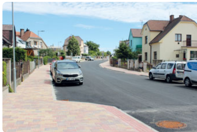
Práce na ulici Konecchlumského pokračují a velká část povrchů je hotová. Do rekonstrukce je zahrnuta i oprava chodníku v ulici Kryštofa Haranta, včetně revitalizace paloučku. V rámci prací dojde k opravě schodiště k evangelické faře
