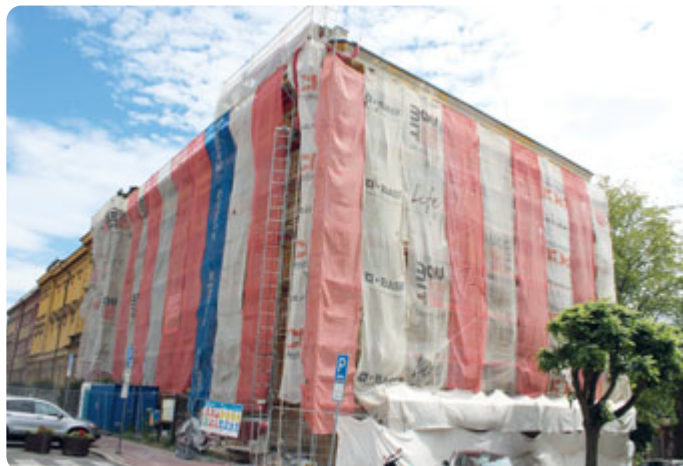
Probíhají investice do škol. Tou největší v současnosti je rekonstrukce fasády a výměna oken u ZŠ Husova, směrem z ulic Fügnerova a Husova. Na ZŠ Poděbradova je také třeba rekonstruovat výřažovnu a v případě ZŠ 17. listopadu se pozornost upíná k opravě střechy
