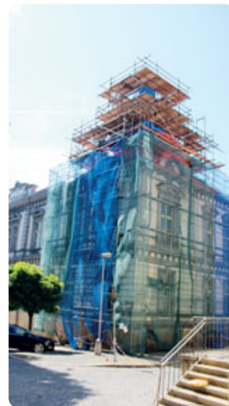
Ve školní budově na rohu ulic Smiřických a Lindnerova probíhá rekonstrukce střechy
