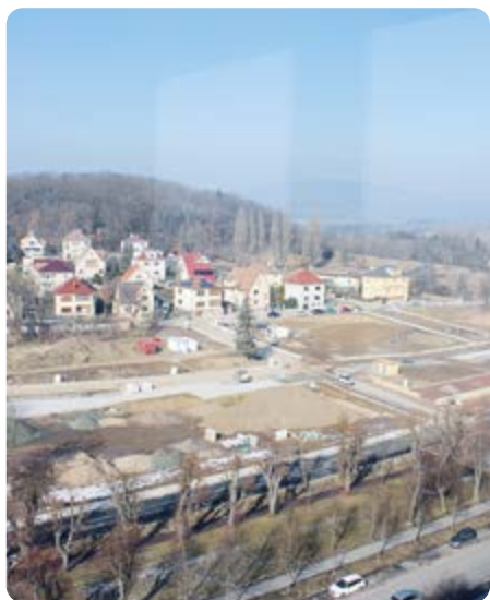
Výstavba infrastruktury pod Čerňovkou je v poslední fázi. Stav na snímku je z poloviny února 2025.
