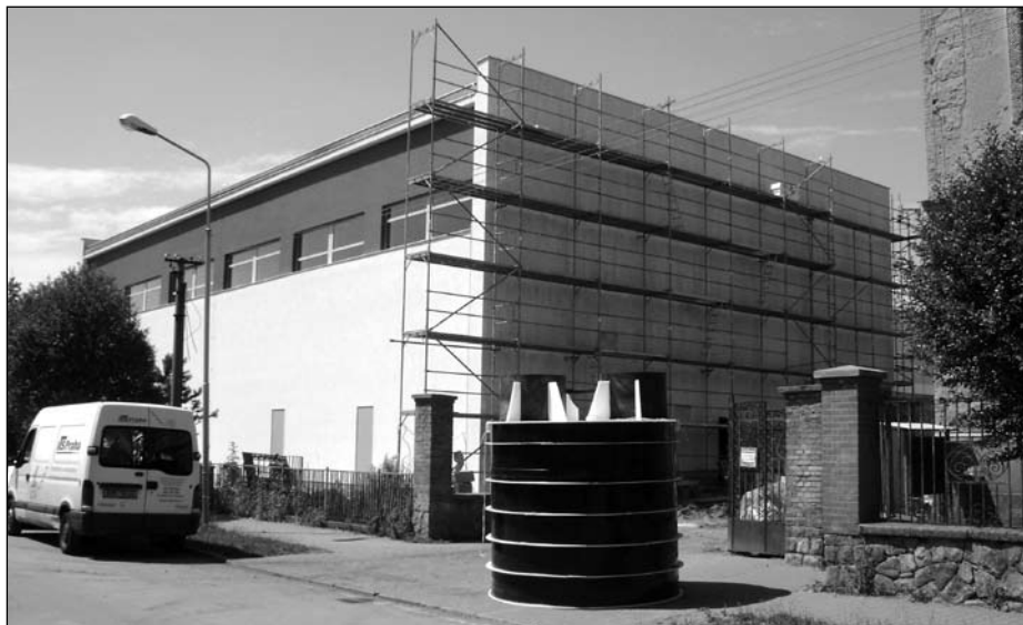
Snímky zachycují výstavbu víceúčelové sportovní haly v Kopidlně v době, kdy práce spějí do svého závěru. Nebude trvat dlouho a hotová stavba přivítá první sportovce.
