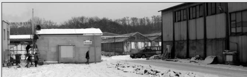
Celkový pohled na budovu nové kotelný zahradnické školy
