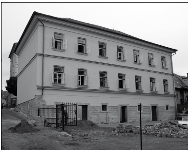
Kulturní a vzdělávací centrum v Kopidlně těsně před dokončením.
