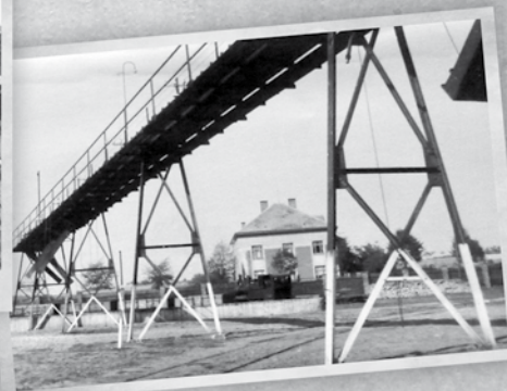
Dopravník vylouhovaných řízků - vzadu pohled na vilu cukrovaru.
