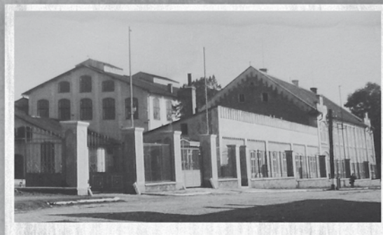
Vjezd do cukrovaru: hlavní brána s administrativní budovou a byty.
