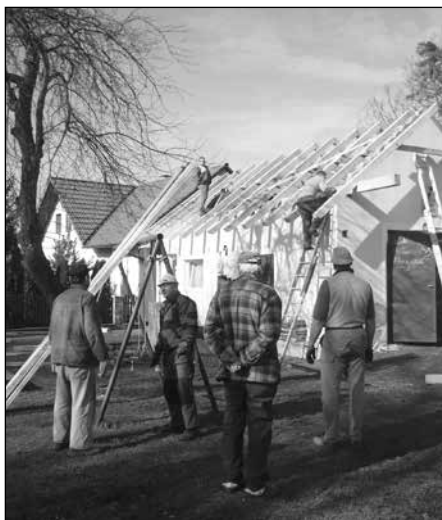
Práce na výměně střešky hasičárny ve Mlýnci, duben 2013.
