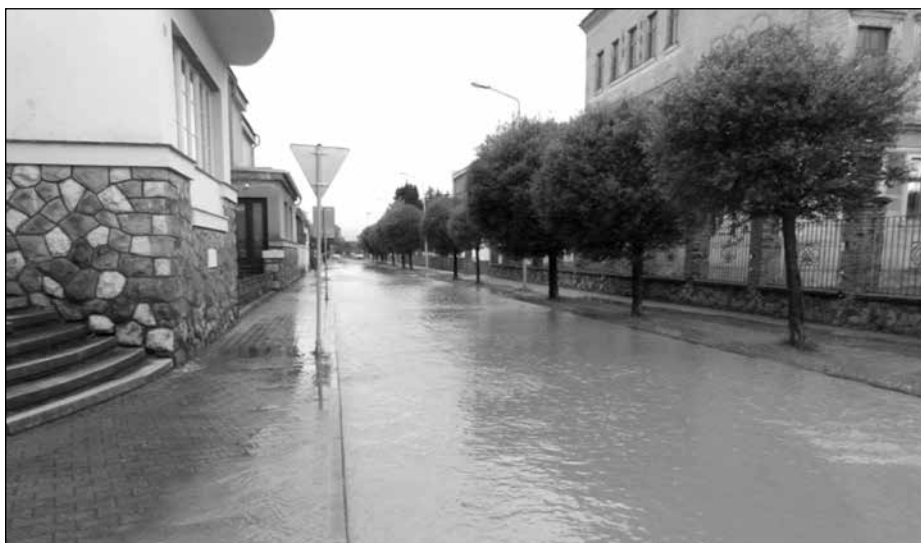
Při bleskové povodni v červnu 2013 nebyla ušetřena ani sokolovna. Zatopeny byly prostory suterénu a kotelna. Kotel umístěný pod úroveň okolního terénu se ocitl celý pod vodou.
