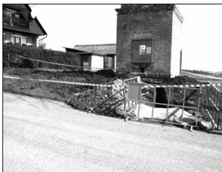
Okolí trafostanice v průběhu nutných výkopových prací na podzim roku 2014.
