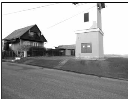
Pozemek kolem trafostanice po kultivaci manželi Spáčilovými v dubnu 2015.
