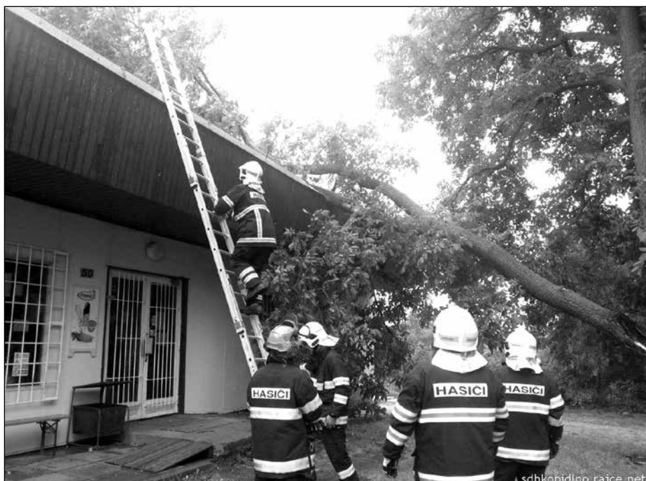
19. 7. 2015 / Pševy / spadlá větev na budovu
