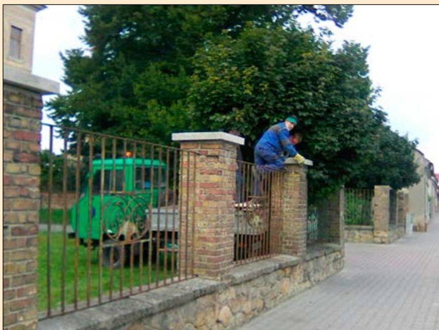
OPRAVENÉ SLOUPY PLOTU V září pracovníci Místního hospodářství opravili sloupky oplocení u základní školy v ulici Tomáše Svobody. (kl)
