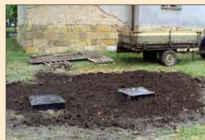
U bývalé školy v Mlýnci byla odstraněna stará rozpadlá jímka a nahrazena zcela novou funkční jímkou splňující současné požadavky v oblasti ochrany životního prostředí. (kl)
