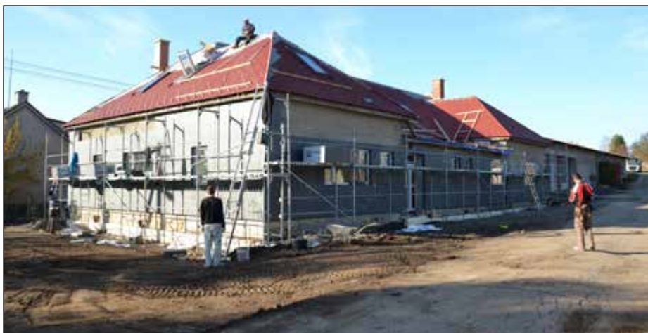
Po vnějším plášti požární zbrojnice přišly přes zimu na řadu práce především v interiéru.
