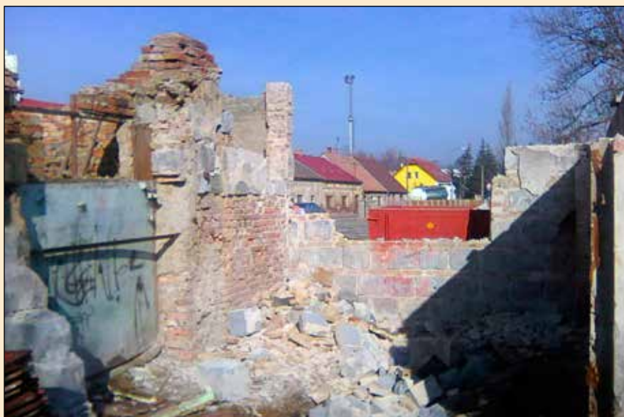
Před plánovanou demolicí domu čp. 23 v Jičínské ulici v Kopidlně pracovníci Místního hospodářství již letos vyklidili dvůr a hospodářské budovy. Po demolicí se plánuje zpevnění vzniklé plochy a její využití pro parkování aut. (kl)
